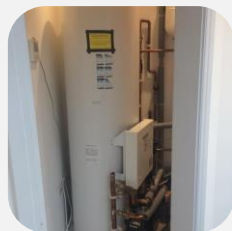
Thermal store: Hot water cylinder
